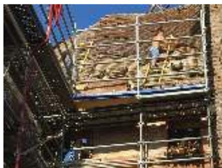
opérations de dépose de la toiture avec reprise des tuiles, rénovation et renforcement de la charpente bois. Enfin, les murs des tourelles, sont eux aussi actuellement en cours de restauration.
